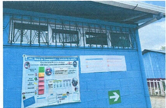
Foto 4: CANALES Y BAJADAS DE AGUA
