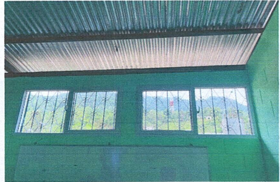
Foto 2: ESTRUCTURA DE TECHO
